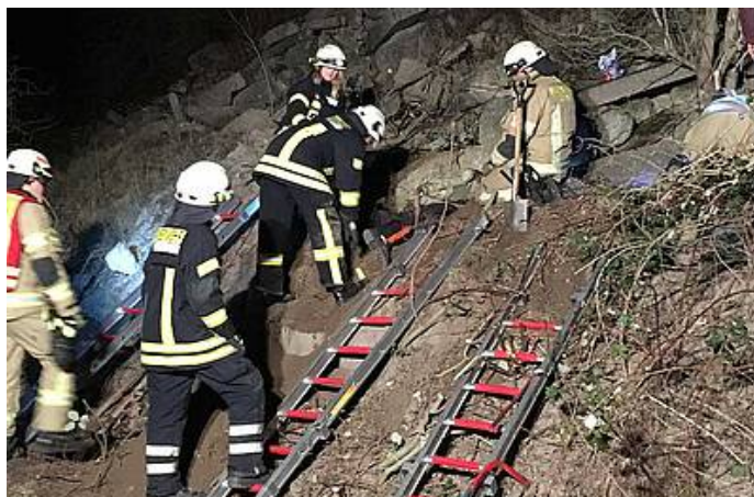
Einsatzkräfte von Feuerwehr und THW mussten sich in einen Geröllberg graben. / Feuerwehr Lehrte
