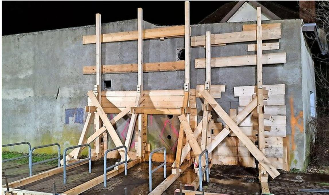
Stundenlanger Einsatz: THW Lehrte und Ortsfeuerwehr Hänigsen stützen nach einem Schwelbrand eine Hauswand mit einer Holzkonstruktion ab. Foto: Uwe Richter/Feuerwehr
